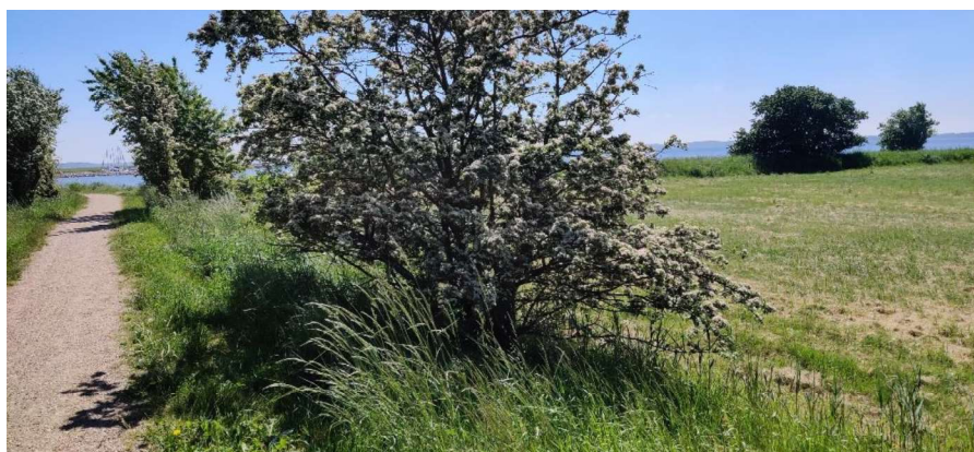
Figur 4.6: Billede af sydligste del af dige op mod Sømærkevej, Foto E
